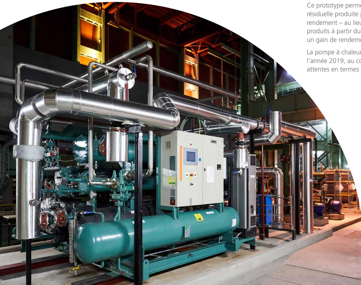
Ce prototype permet la récupération d'une plus grande partie de la chaleur résiduelle produite par l'unité de cogénération, afin d'en augmenter encore le rendement – au lieu d'évacuer la chaleur résiduelle dans le canal. Les 300 kW produits à partir du circuit de refroidissement à basse température équivalent à un gain de rendement de 3%.
